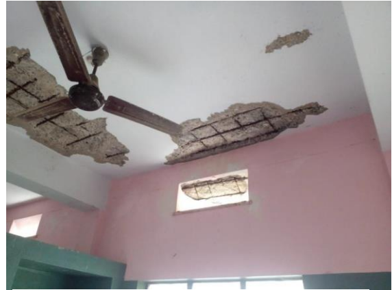
Te repareren scheuren in het plafond
