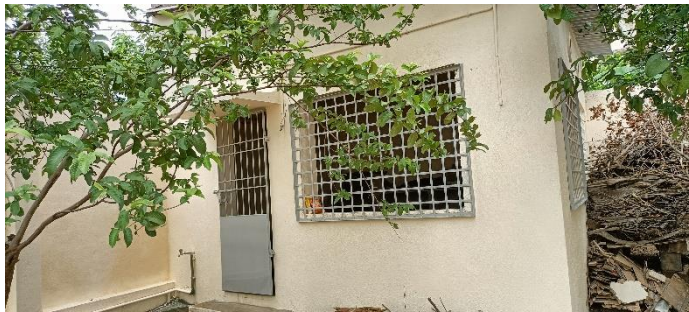
Avadi: Renovatie ramen en deuren
