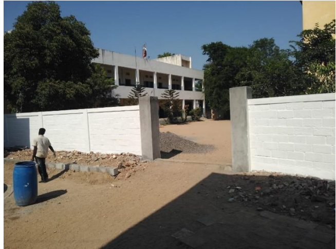
Nieuwe scheidingsmuur tussen Primary en High school, met doorgangspoort
